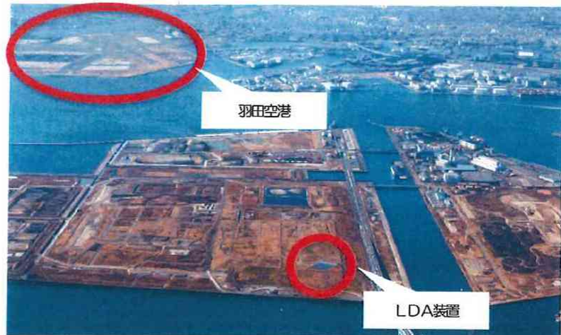
参考図 11 中央防波堤埋立地に設置されている LDA 装置 (羽田空港に着陸する飛行機が安全に着陸できるように設けられた装置)
